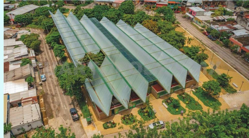
En la categoría Centros Comerciales, por ser obra sustentable que usó materiales de la región, como su techumbre inclinada compuesta por una estructura metálica y paneles de bambú, que proporcionan espacios frescos; la cresta en zigzag de la cubierta permite la iluminación natural y la captación de agua de lluvia para su uso en baños y jardines. Así lo informó la Secretaría de Desarrollo Agrario, Territorial y Urbano (Sedatu)
