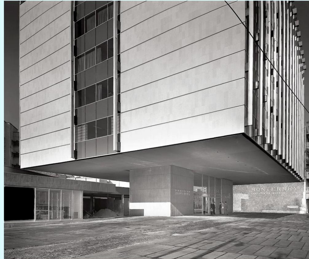
La planta baja y el primer piso de oficinas son de doble altura para permitir apreciar el voladizo de 11 metros entre los apoyos y tensores. Con ese mismo propósito se remitió un volumen de un piso en la planta baja, con superficie rentable. Todo el conjunto mostró una plaza cubierta.
