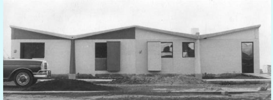
Los prototipos, de 50 m<sup>2</sup> de superficie cubierta, se proyectaron para una colonia aislada que formaría parte de Ciudad Nezahualcóyotl. Cada uno consta de estancia comedor, dos recámaras, cocina y baño. Van cubiertos por cuatro cascarones paraboloides-hiperbólicos de concreto.
