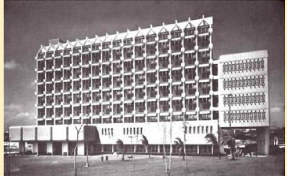
Considerando las condiciones climaticas, el cuerpo de hospitalización se elevó para obtener el mejor ambiente; además para evitar la entrada del sol a las camas, se diseñaron unas viseras soportadas por las columnas exteriores, provocando una visión optica especial. La consulta externa en planta baja, cuenta con aire acondicionado
