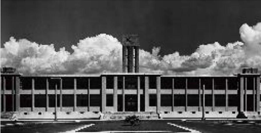
En la fachada del Hospital de Tuberculosos Huipulco, donde están situadas las salas de curaciones o para encamados, se requirió de una aeración constante, lo que fue aprovechado por el arquitecto, colocando los elementos constructivos de concreto armado en dos elementos horizontales, el entepiso y la balaustrada, que contrastan con las columnas verticales de la estructura, según un ritmo y medida armónica, en que predomina la horizontalidad.
