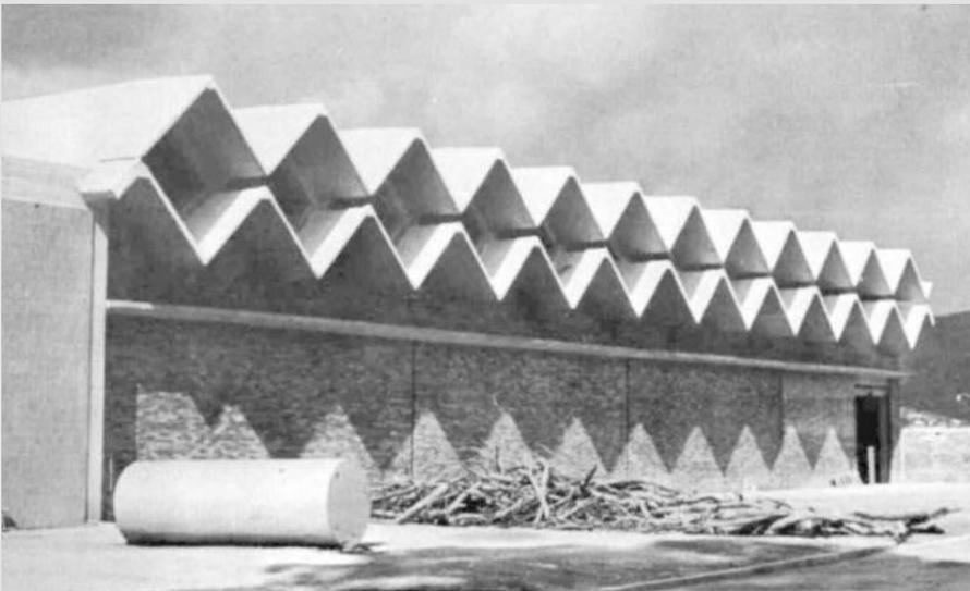
La fabrica cuenta con dos elementos independientes: Oficinas y sala de trabajo, con trabe losas de 15 metros de claro, formando en sus intersecciones ventanas que producen iluminación superior.
