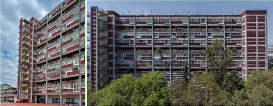
El diseño se llevó a cabo con dos tipos de edificios: siete, ligados entre sí en todo el terreno en forma de zigzags entre sus extremos y cada uno cuenta con trece niveles, doce de vivienda y la planta baja para comercios. El otro, en dos edificios ubicados en las esquinas opuestas en cuerpos individuales, también verticales.
