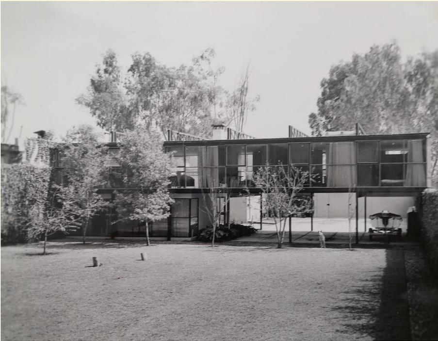
Al ser el acero un material de alta resistencia y limpieza constructiva, su ingeniería de sistemas se une perfectamente a la arquitectura de sistemas, permitiendo espacios interiores libres de elementos de la estructura que impidan un libre manejo de las áreas.
