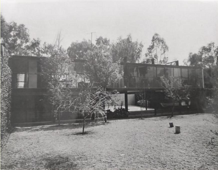
En esta edificación la primera losa tiene traveses sustentantes normales y la superior, traveses invertidos, para obtener un plafond sin obstáculos. En esta obra la mayoría de los muebles fueron diseñados y fabricados por ellos.
